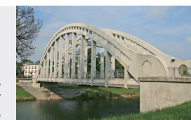
Železobetonový most v Karviné-Darkově
