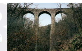
Železniční most v Žampachu
